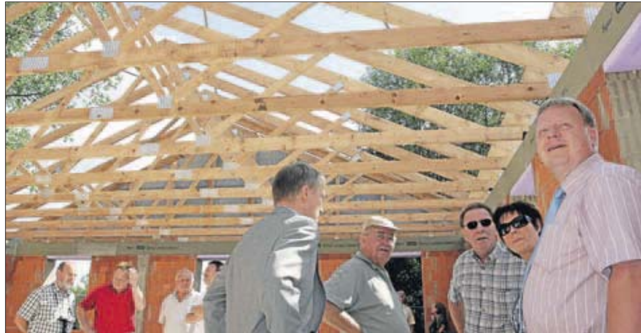
Beim Richtfest führte Bürgermeister André Lohmann (rechts) durch den Rohbau.
