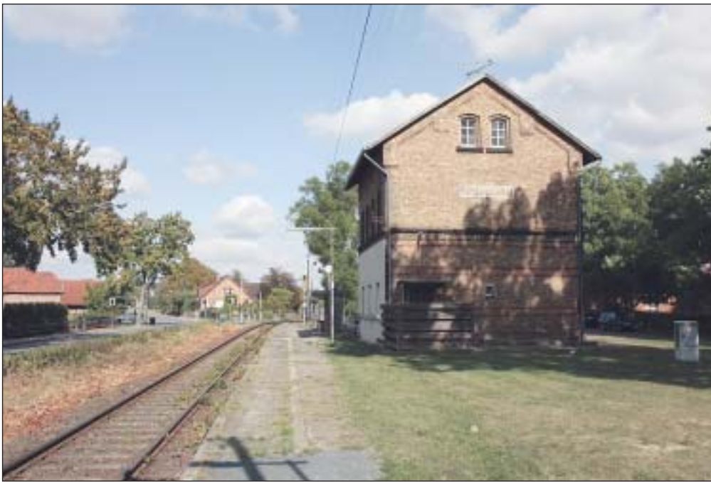
Bahnhofsgebäude in Rötgesbüttel: Der Rat hat mit knapper Mehrheit entschieden, das Bahnhofsgebäude umzubauen und dort das Bürgermeister-Büro einzurichten. Photowerk (co)
