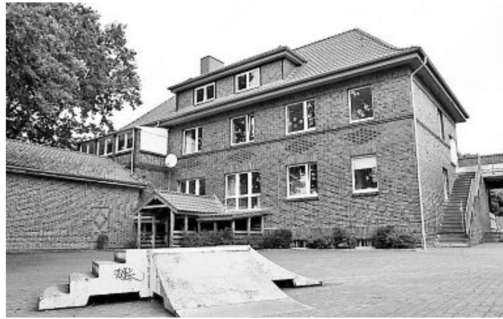
Kindergarten Rötgesbüttel: Die neue Krippe soll in einem Anbau Platz finden. Die Gemeinde investiert dafür 500.000 Euro. Photowerk (co)
